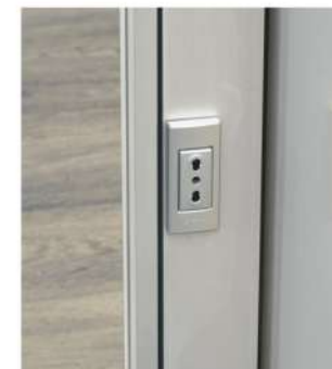
Presse montante porta Door jamb plug
