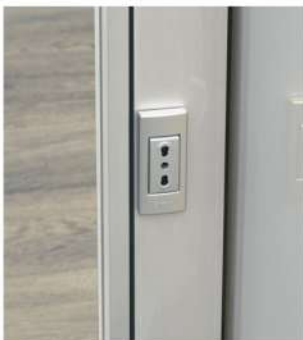
Presa montante porta Door jamb plug
